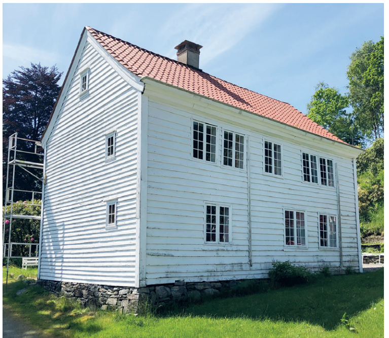
SØ- og NØ-veggen skrapet og grunnet.
