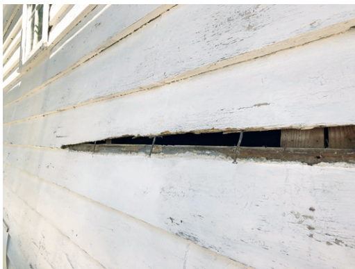
Råteskader på SV-veggen ble utbedret med nye kledningsbord.
