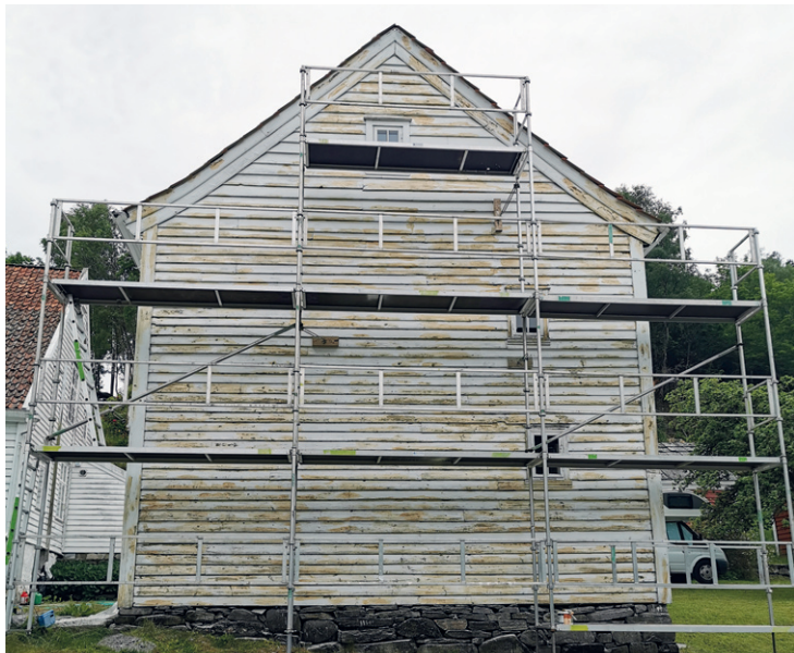
SØ-veggen skrapet og grunnet
