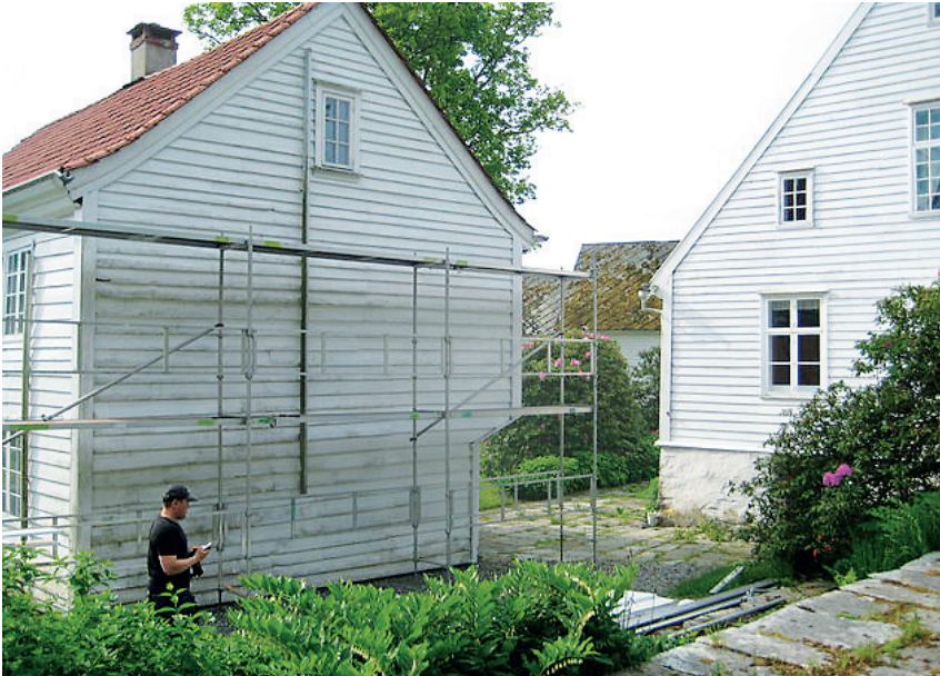
Nye kledningsbord på NV-veggen, gjenbruk i gavlen. Brannstigen ble demontert og flyttet til NØ-veggen på Hovedhuset (th).
