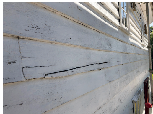
Råteskader på SV-veggen ble utbedret med nye kledningsbord.
