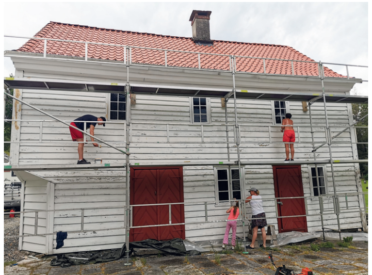
Fossefamilien stilte opp med 11 deltagere for å fullføre vedlikeholdet av BISPESTOVA: SV-, SØ og NØ-veggen ble skrapet, grunnet og malt med to strøk.
