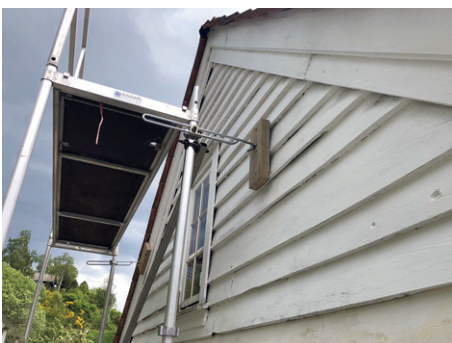
Sikring av stillaset.
